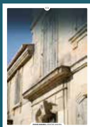
03 les façades en pierre de taille
