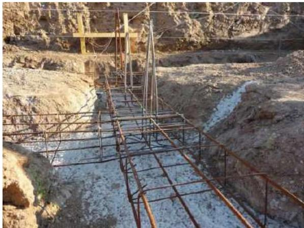
**Exemple de continuité mécanique entre fondations et des fondations avec les chaînages verticaux**
