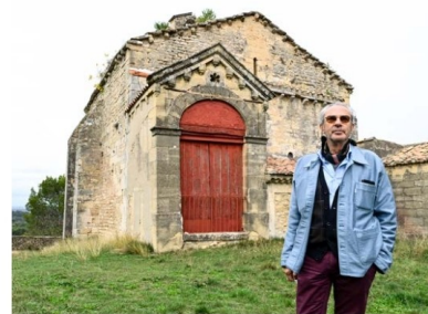
Le maire de Saint-Étienne-du-Grès, Jean Mangion, veut commencer les travaux de restauration dès 2026.
