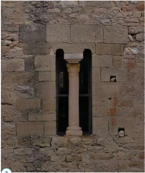
3 Orthophotographie : Atelier du vide, 2022 Une baie rectangulaire se dresse au dessus de l'accès, permettant d'éclairer la tribune. L'extérieur de la baie est formé par un linteau à double cintre (créant ainsi une baie géminée) qui repose sur une colonnette centrale à fût cannelé. L'aspect et la position de cette dernière laissent penser qu'elle a subi des modifications au fil des siècles.
