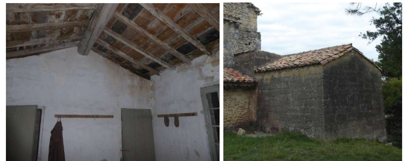
Fig 20. La pièce annexe, maçonnerie de pierres de taille ©EQ
