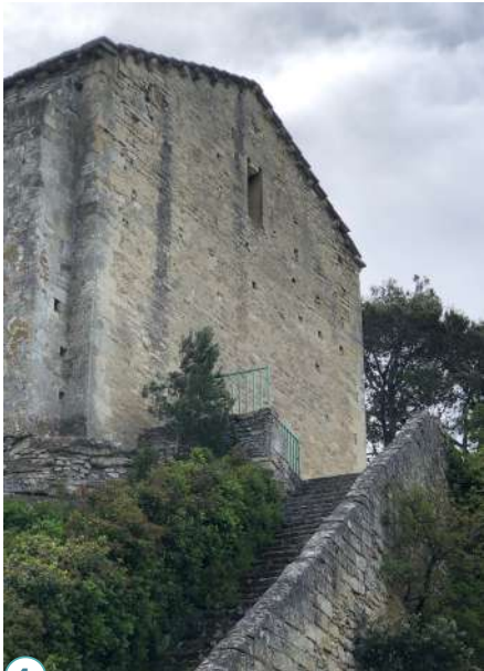
1 Cliché : Architecture & Héritage, 2022 La façade ouest de la chapelle de Notre-Dame du Château a été construite vers la fin du XIe siècle trônant au sommet d'une colline. L'escalier qui monte vers la chapelle a été rajouté vers la fin du XVIIIe siècle.
