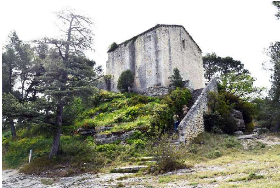
Vue sur les façades nord et ouest depuis le pied du grand escalier extérieur
