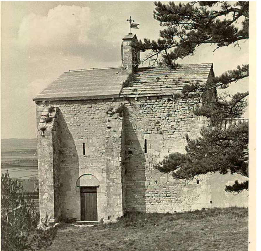
FIG. 11 Vue de la façade Sud en 1966 avec la dalle en béton sur la toiture. s. CRMH PACA Dpt13 0419
