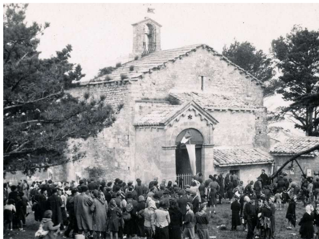
Vue de la façade Est en 1937. A cette époque, le tirant métallique au-dessus de la porte d'accès à la chapelle dite « extérieure » a été déjà installé ainsi que la dalle en béton de la toiture.
