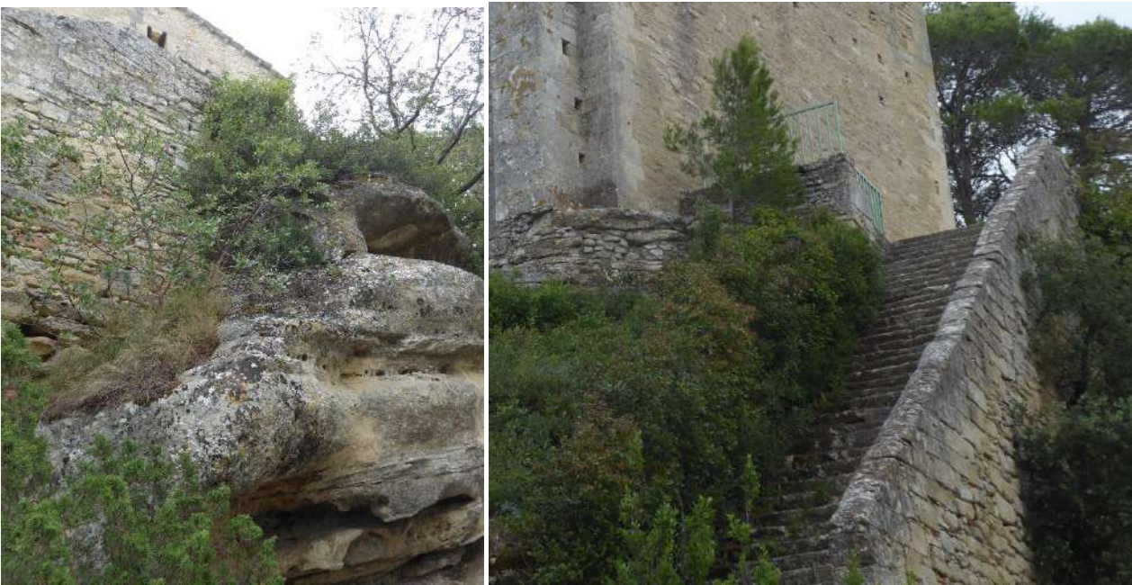
Fig 9. Escalier d'accès à la chapelle et ses appuis ©EQ
