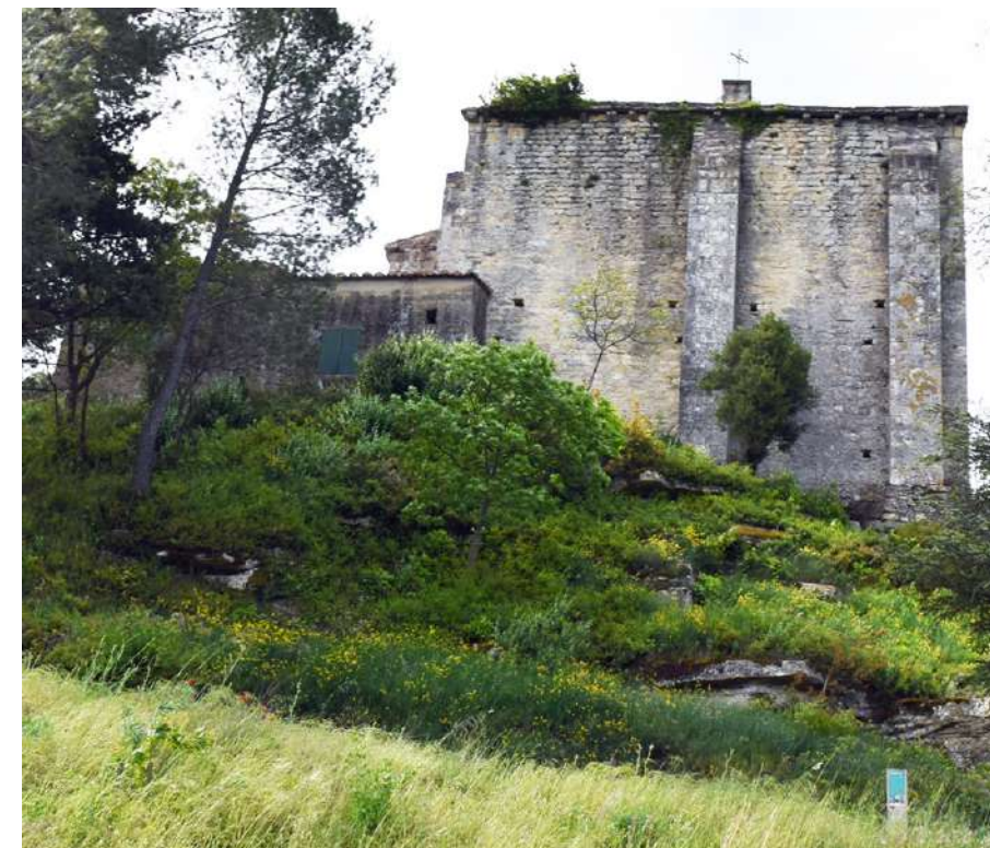
La façade nord, aveugle et pourvue de deux contreforts comme la façade sud. On y observe les nombreux trous de boulins de l'échafaudage médiéval, qui montrent un chantier homogène.
