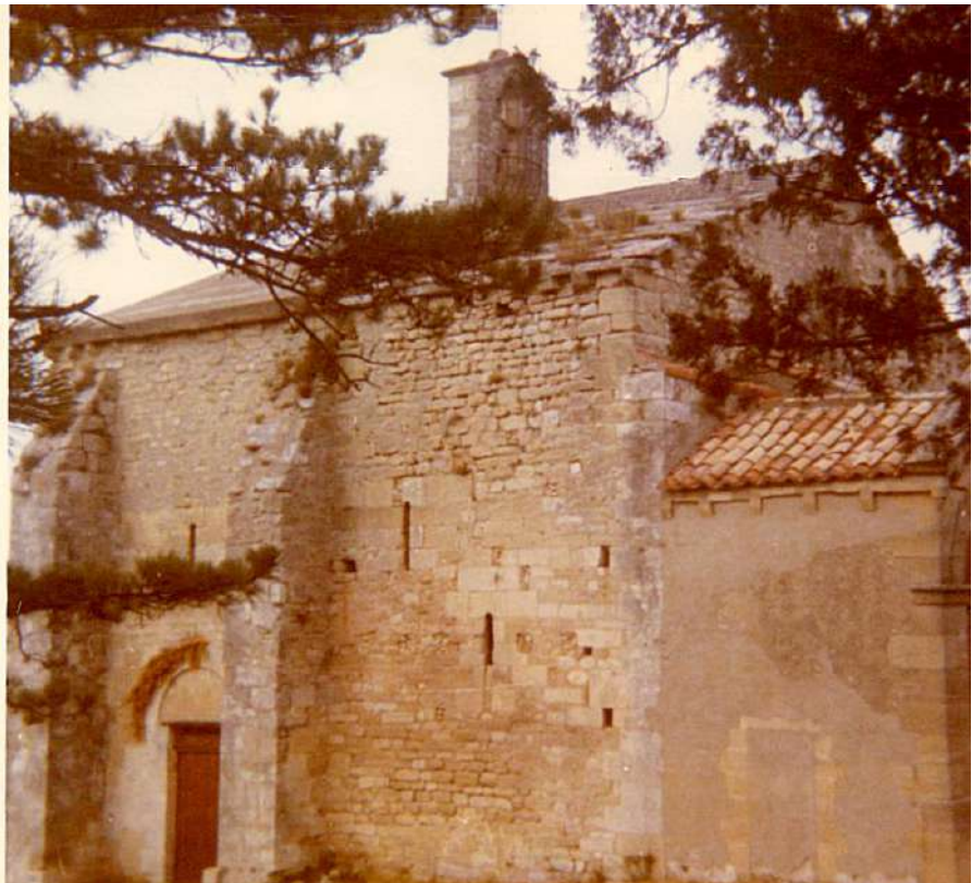
FIG. 12 Vue de la façade Sud en 1970 avec la dalle en béton sur la toiture. s. CRMH PACA Dpt13 0419
