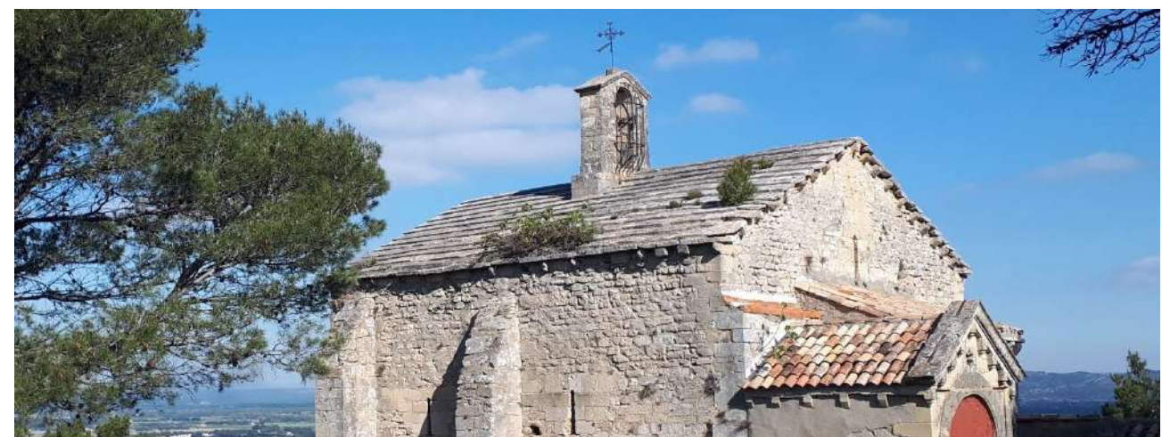
Fig 15. Les toitures de la Nef ©Architecture & Heritage
