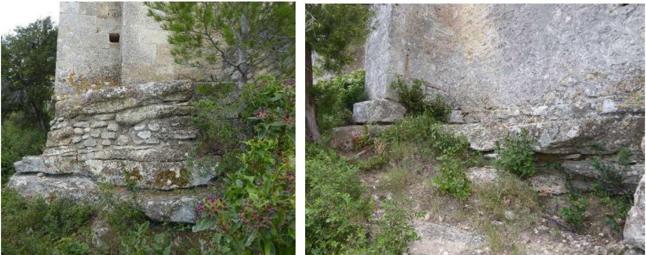
Fig 6. Soubassement de la chapelle en aval, façade Nord ©EQ
