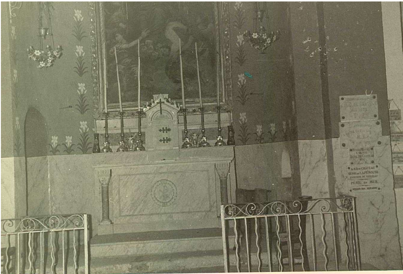
Vue de l'ancienne disposition du chœur montrant le maître-autel en marbre, le tableau de l'Assomption, les décors peints du XIXe siècle et le banc de communion en fer forgé. Photographie prise en 1966. s. CRMH PACA Dpt13 0419
