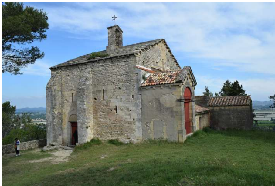
Vue du sud-est, les bâtiments annexes accolés au chevet se démarquent nettement de l'édifice médiéval dans leurs modes constructifs.
