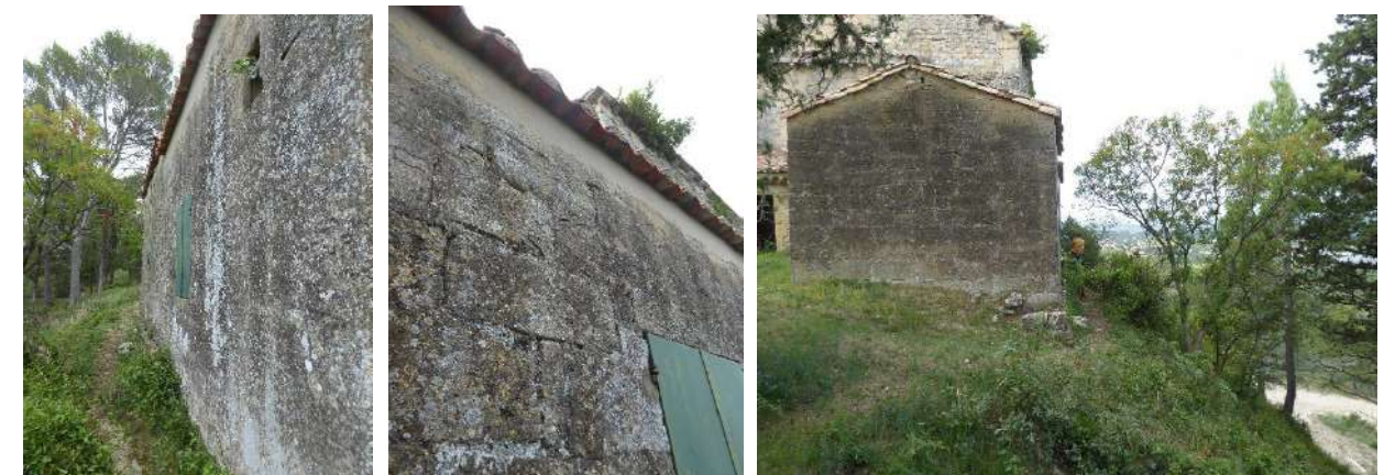
Fig 21. Sacristie et sa pièce annexe ©EQ
