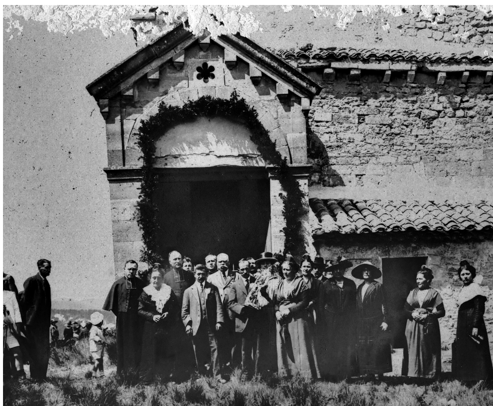
Vue de la façade Est en 1923. Le tirant métallique au-dessus de la porte d'accès à la chapelle dite « extérieure » n'était pas encore installé. Cependant les pierres commençaient déjà à se dissocier.
