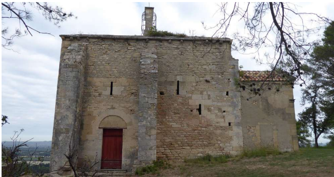
Fig 12. Façade Sud ©EQ
